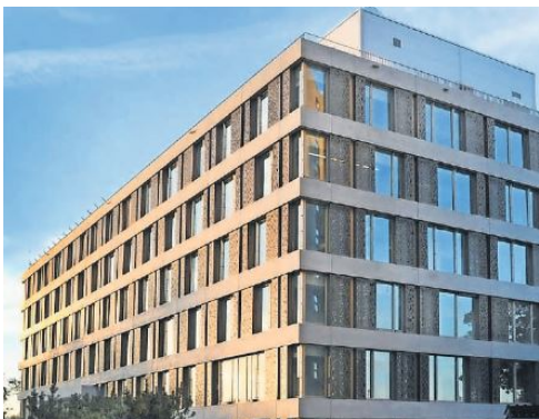
Auf dem Dach des neuen KSB Partnerhauses befindet sich ein Helikopter-Landeplatz. zvg
